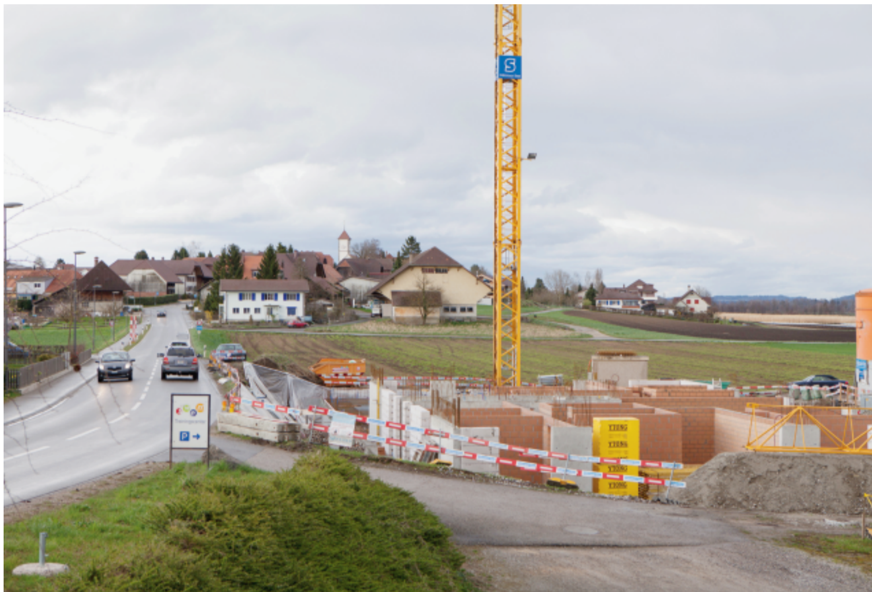
Das Untergeschoss steht schon: Die beiden Mehrfamilienhäuser werden ausgangs Finsterhennen, nur einen Steinwurf von Siselen entfernt, erstellt.
